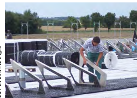
„Fixodrain XD 20“ ist auch die richtige Basis für die Kombination „Grün und Solar“ und sorgt für eine vollflächige Drainage unterhalb der Solaraufständerung.
