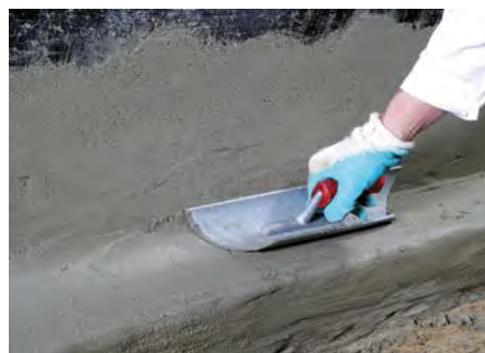
Dichtungskehle aus „WP DS Levell“ mittels Rundkelle „frisch in frisch“ einbringen.
