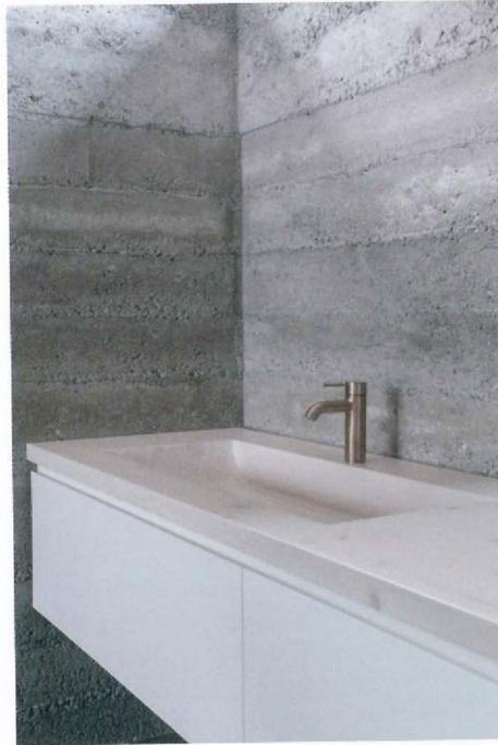
Stampfbetonwände | Rammed concrete walls
