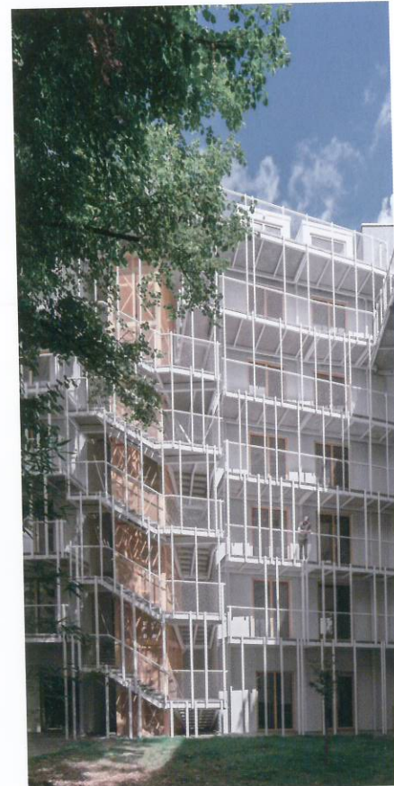
Ansicht vom Hof | View from the courtyard
